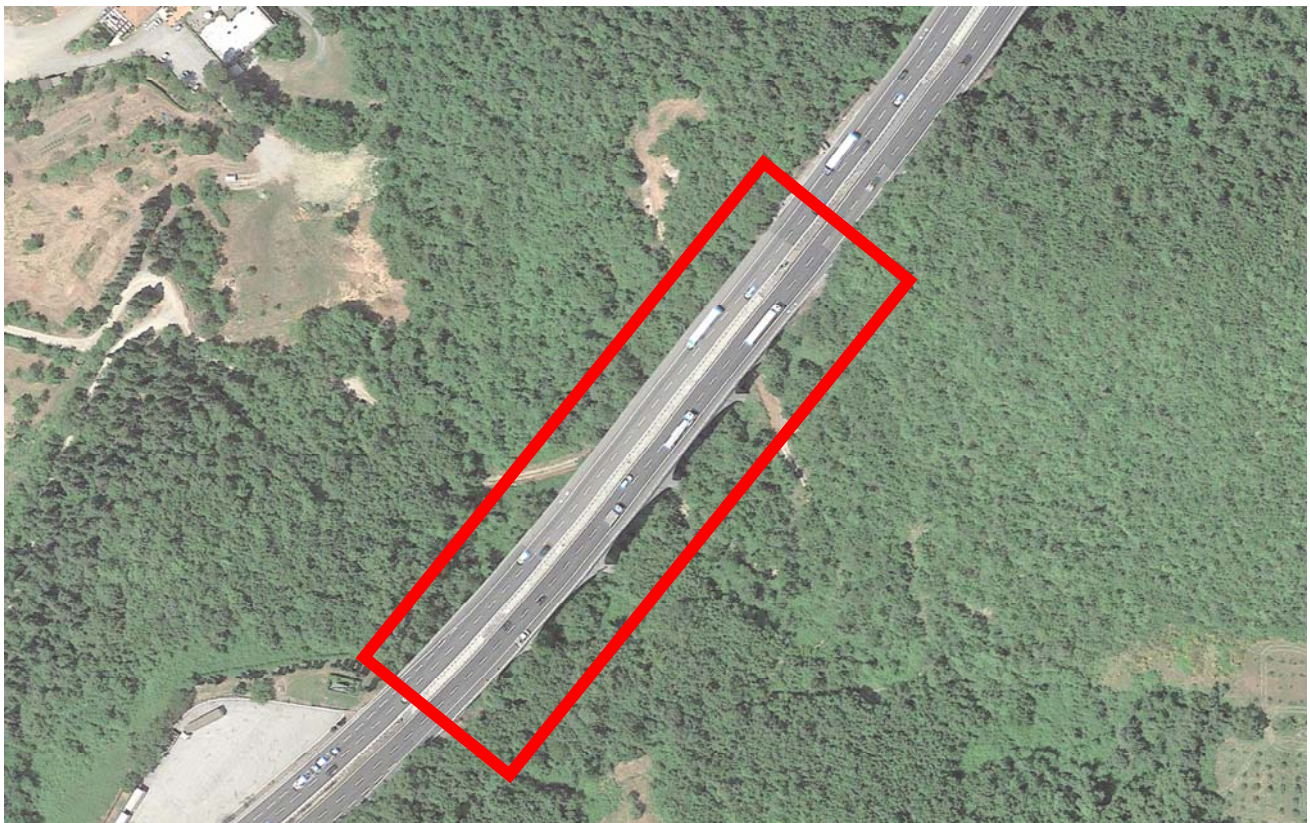
Figura 3 - Vista aerea con collocazione dell'opera
