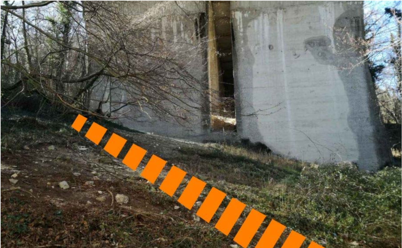
Figura 17 – vista 7, in arancione è indicata la pista di cantiere in corrispondenza dell'arco n°4
