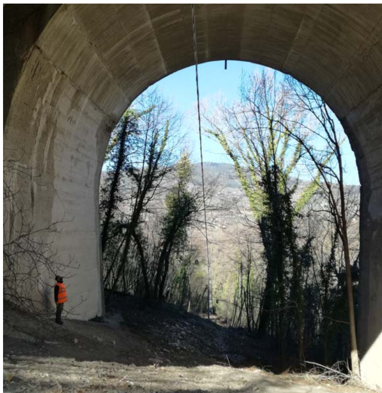
Figura 18 – vista 8, interferenza con linea telefonica nella campata n°7
